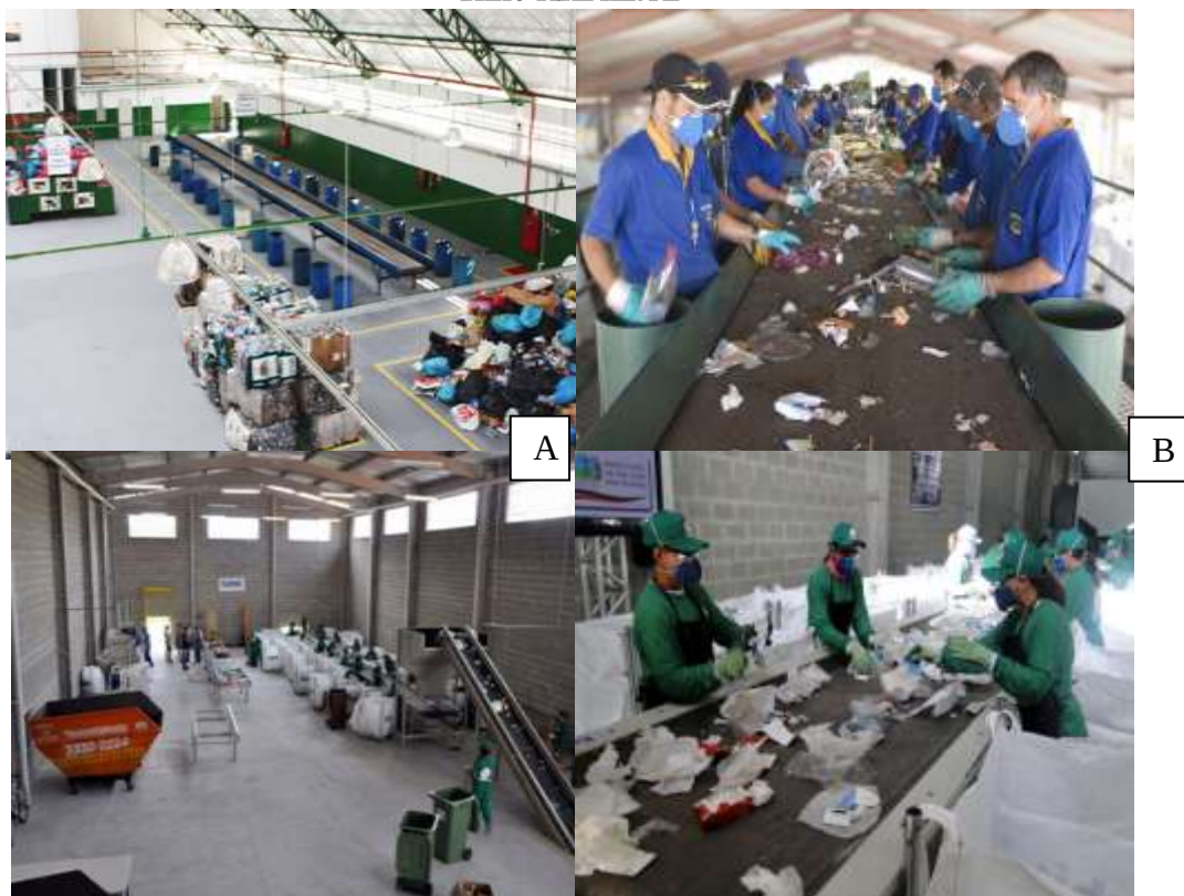
Foto 28 – Infraestrutura do galpão de triagem (A e C – Distribuição dos equipamentos no galpão; B e D – Es[trutura] mecanizada sendo utilizada) – imagem ilustrativa.
