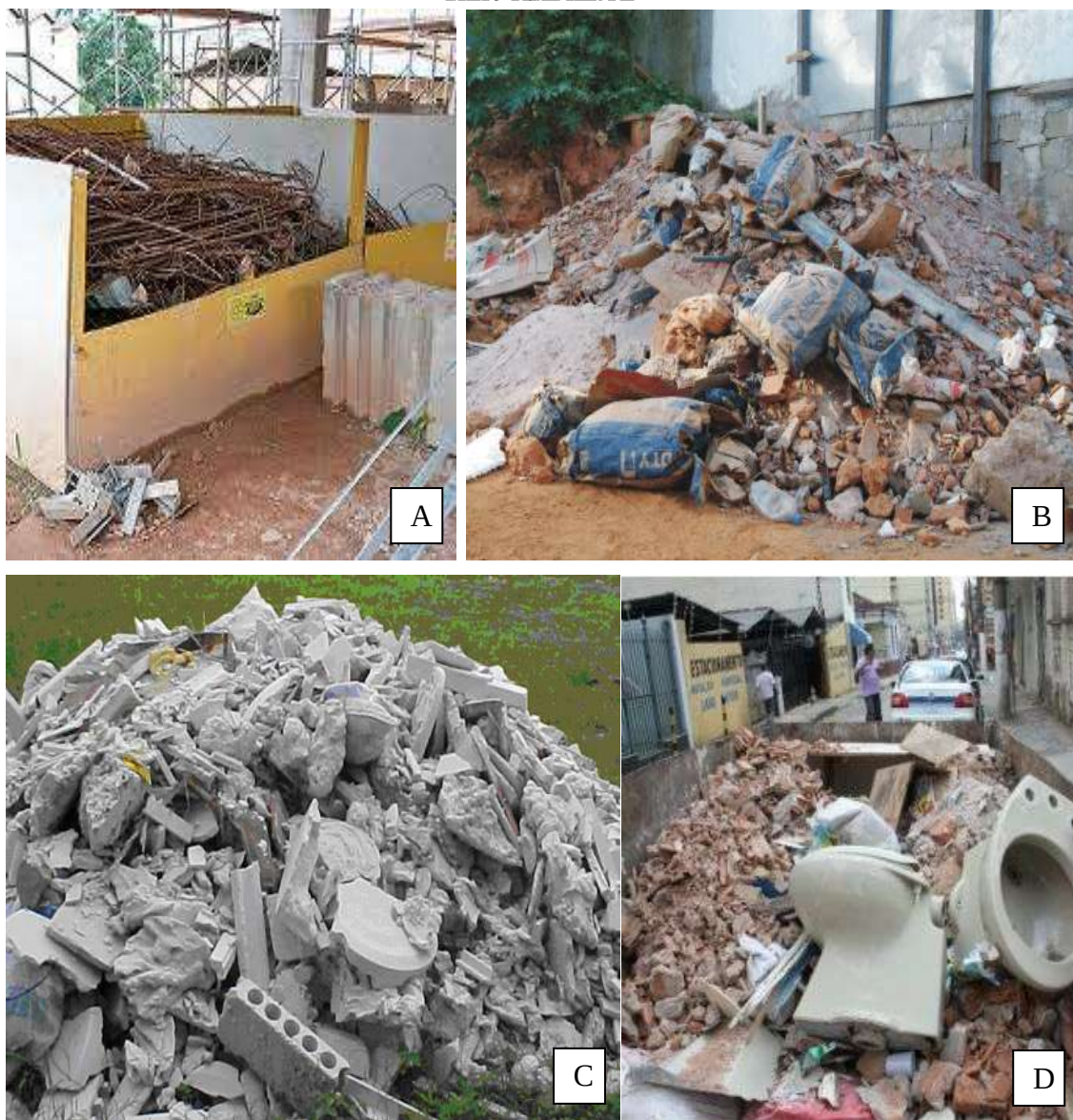
Foto 18 – Resíduos de construção civil (A – Resíduo metálico; B – Resíduos gerais; C – Resíduo de concreto; D – Resíduo na caçamba) – imagem ilustrativa.
